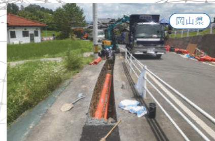
岡山県 美作太陽光発電所自営線管路工事
