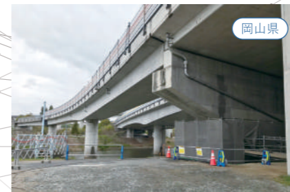
岡山県 山陽道耐震補強工事
