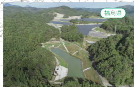
福島県白河太陽光発電所建設工事 20MG
