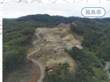
福島県 郡山造成工事 240 万 3 m
