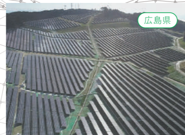
広島県廿日市市メガソーラー築造工事 44MG
